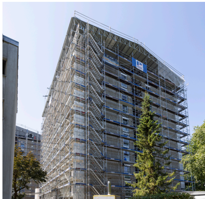
Sanierungsarbeiten am Gebäudebestand im Quartier
