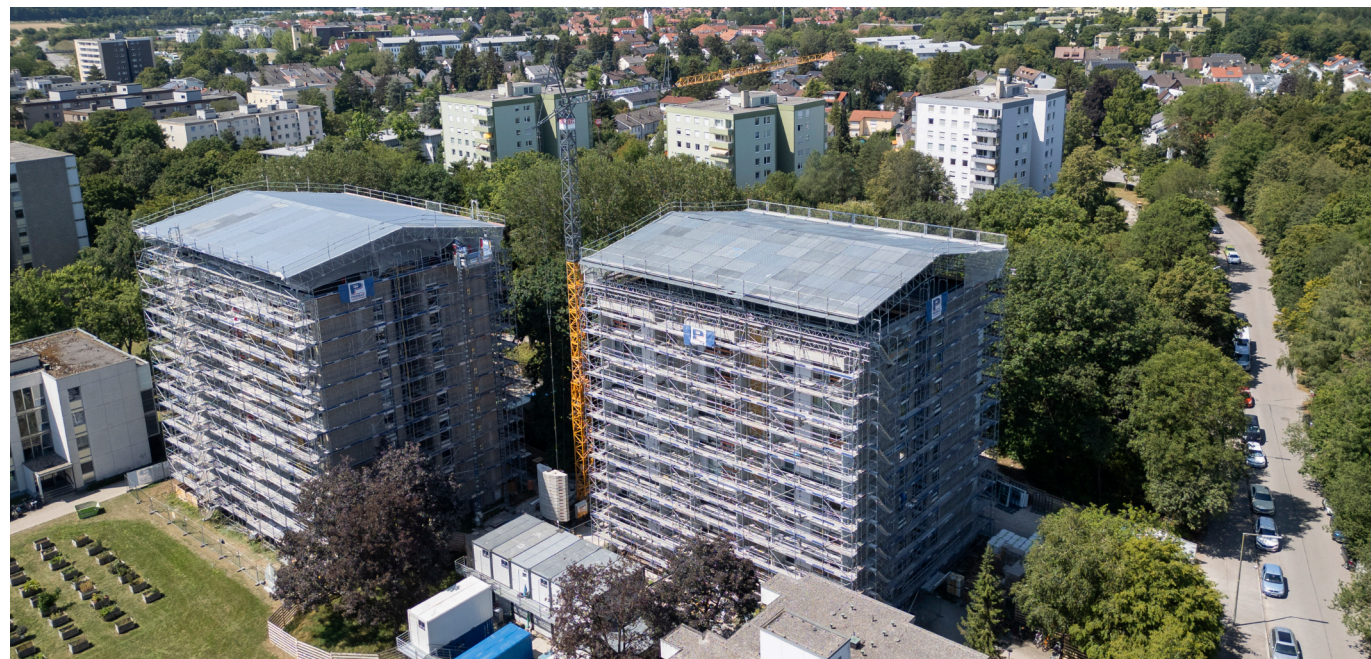
Wetterschutzdach bei Sanierungsarbeiten im Quartier
